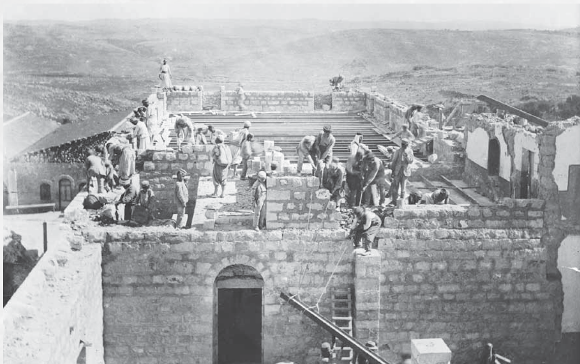
איור 4: בניית האגף הצפוני בבניין הראשי של שנלר (1900). במרכז התמונה, העלאת קורת ברזל עבור התקרה (ארכיון התצלומים, יד יצחק בן-צבי)
