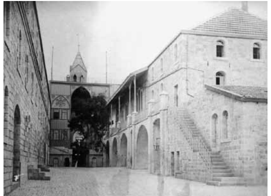
איור 2: אגף הכנסייה בבניין המרכזי של בית היתומים שנלר עם סיום עבודות הבנייה (1890). ברקע מגדל הפעמונים העשוי העץ
