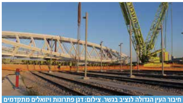
הובלת מפתח הגשר על גבי עגלות. צילום: דגן פתרונות ויזואלים מתקדמים
